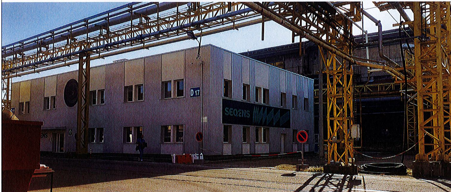
Photo de l'existant
